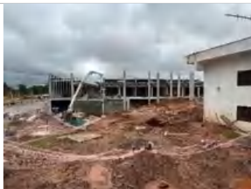
Expansão – em obra
