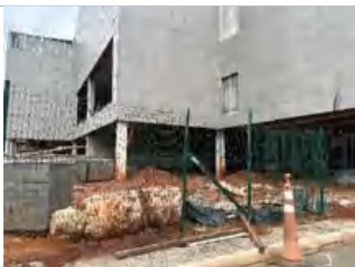
Expansão – em obra
