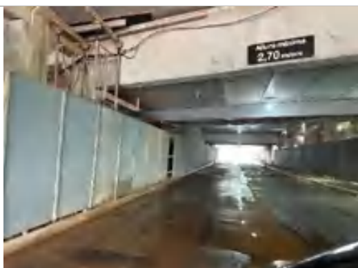
Expansão – em obra
