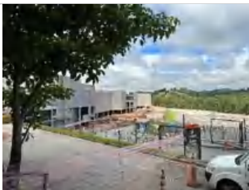
Expansão – em obra
