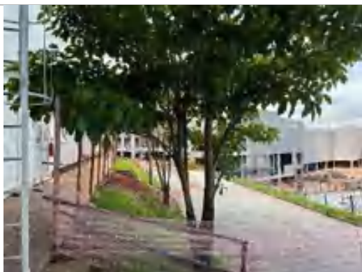
Expansão – em obra
