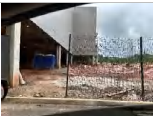
Expansão – em obra
